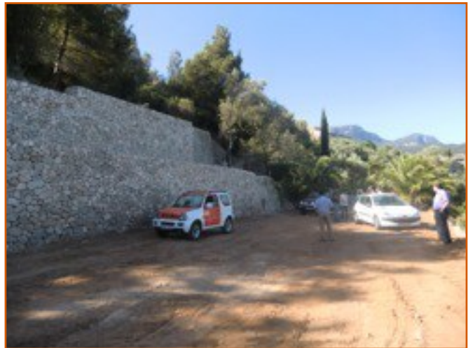
Personal de l'Agència comprova la demolició efectuada per l'Ajuntament de Deià a Llucalcari (15/06/2012)
